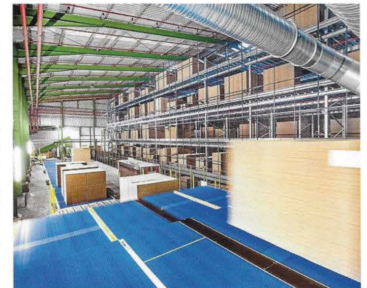
Ansicht des automatischen Formatlagers.
