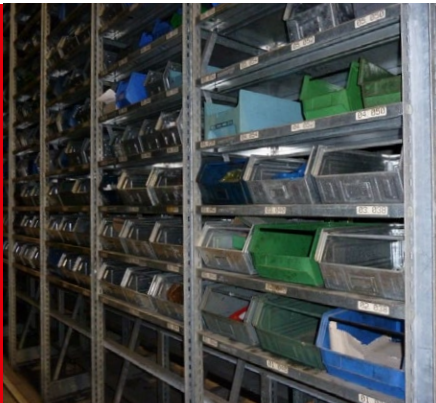
Vor dem Umbau: Fachböden mit Schäfer-Kästen. Before retrofit: Rack shelves with Schaefer boxes.
